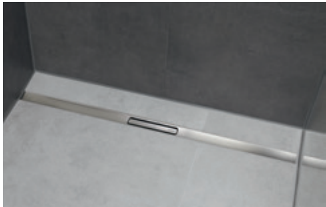
↑ Wystarczy lekkie naciśnięcie palcem, aby zdjąć pokrywę odpływu znajdującą się nad zintegrowanym wkładem grzebieniowym.
