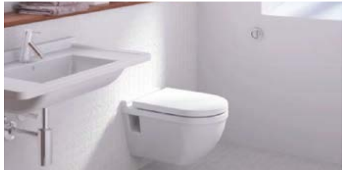
Wykończenie łazienki, dostęp do wnętrza spłuczki zapewniony od góry.
