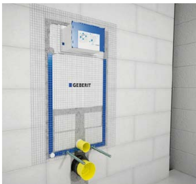
3. Uszczelnienie wszelkich szczelin w murze wokół elementu instalacyjnego i otynkowanie ściany w ramach przygotowań do układania płytek.
