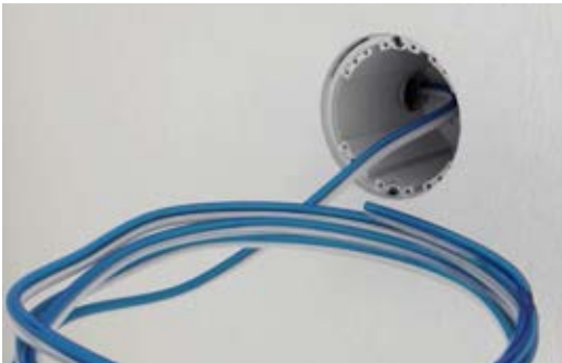
Przeprowadzenie wężyka przez puszkę i peszel do zbiornika podtynkowego.
