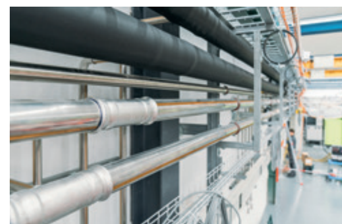
↑ Ekonomiczny i odporny na korozję system przewodów chłodniczych.
