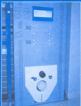
4. Zestaw izolacji akustycznej Geberit składa się z podkładki izolacyjnej pod miskę i ochronnych tulei amortyzujących nakładanych na szpilki montażowe.
