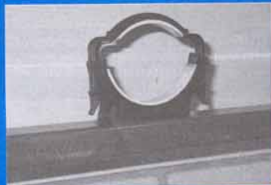
6. Obejma kolana odpływowego w stelażu Geberit Duofix jest również wyposażona we wkładkę tłumiącą.
